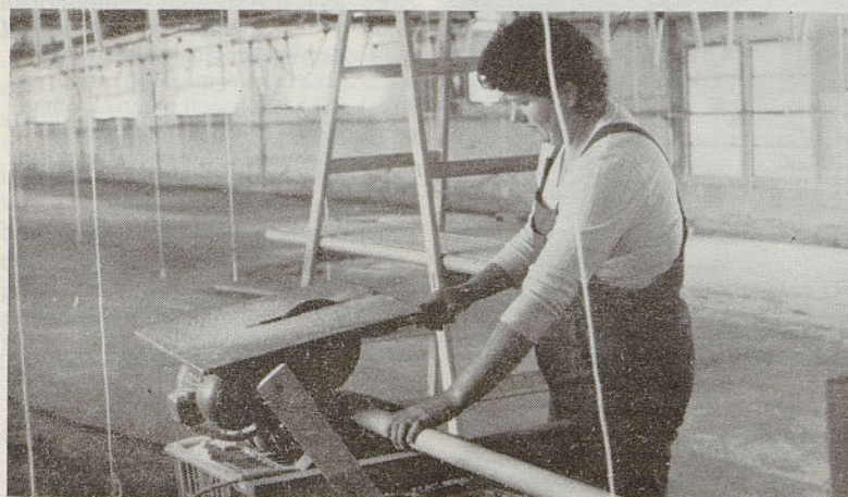
Na farmi Hanjsko so te dni že vselili brojlerje. Pred tem je bilo veliko dela s pripravami in preureditvijo farne. Na posnetku vidite delavko pri krajanju cevi za napajalnike.
