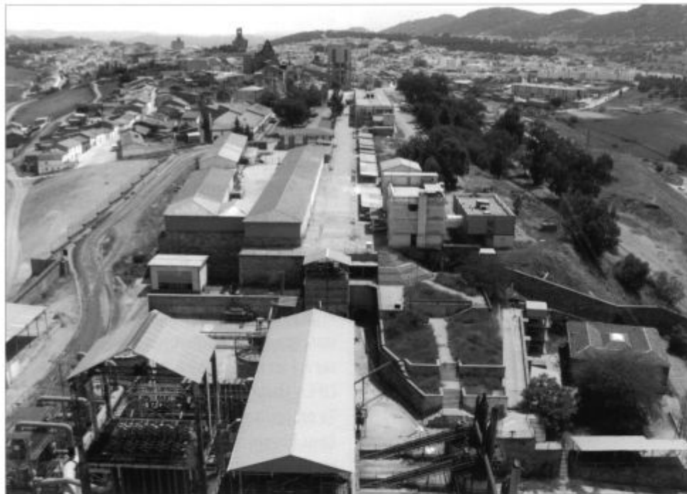
Panoramski pogled s stolpa jaška San Joaquín: naprave, jašek San Teodoro in mesto Almadén
