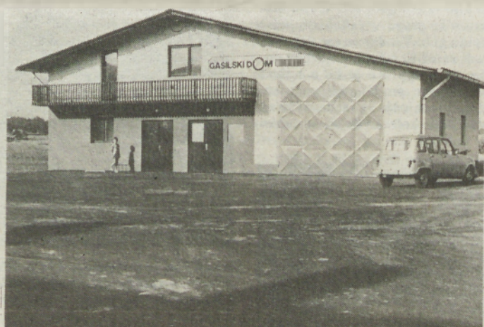
Gasilski dom v Grabah — velika pridobitev gasilcev in vseh občanov.
