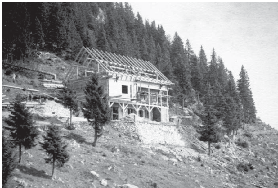
Staro Mozirsko kočo so med vojno požgali Nemci. Po drugi svetovni vojni so jo zgradili višje na bregu. Slika je posneta med gradnjo in jasno kaže, da je stavba veliko večja od stare koče. Sliko je podarila Saša Zver iz Mozirja.
