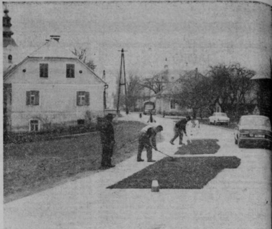
Kot vsaka zima je tudi letošnja prizadejala cestam veliko škode. Cestno podjetje Celje je že pričelo popravljati najbolj poškodovana cestišča na celjske območju, da bodo ceste pripravljene na velike obremenitve v bližajočem obdobju. Na sliki so delavci Cestnega podjetja Celje, pri popravilu ceste na Polzeli. Foto: Tone Tavčar
