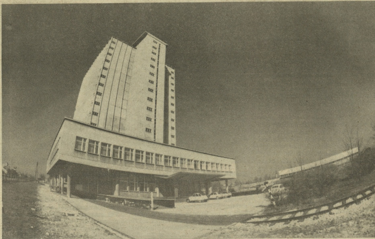
Zaradi velikih izkopov gramoza za Savinjo in močnega podzemeljskega toka žalskih odpadkov se je začel naš Hmezad resno nagibati in ugrevati. V teku so že razgovori z nekim renomiranim podjetjem za sanacijo.
