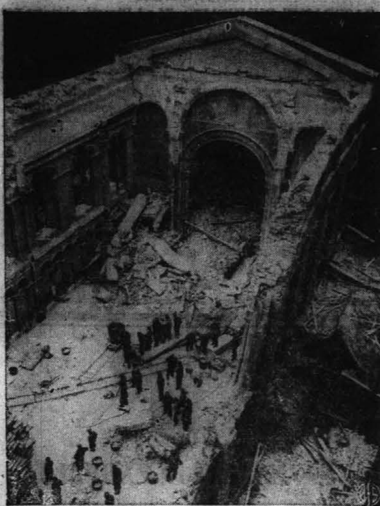
Ni veliko ostalo od slavne Guards Chapel v Londonu, potem ko jo je zadel robotna bomba. Dvomljivo je, da bi jo bilo še mogoče popraviti, kar so ostali samo nekateri odseki stena. Delavci odvažajo razvaline in lišče pod njimi ponesrečence.
