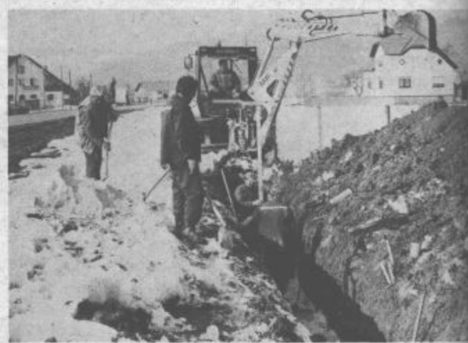
Dela pri urejanju že dalj časa načrtovane kanalizacije naj bi bila končana v prvi polovici prihodnjega meseca.
