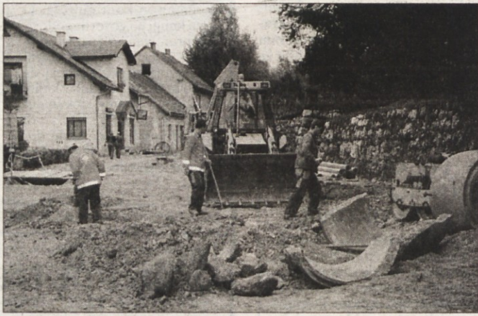
OBNOVA KOLODVORSKE CESTE - V Črnolju naj bi do 20. novembra končali obnovo Kolodvorske ceste od "bele hiše" do hotela Lahinja. Sedaj polagajo cevi za elektroinstalacije za javno razsvetljavo, vodovod, kanalizacijo, za kar bo občina odštela 41 milijonov tolarjev. Iz državnega proračuna pa bo prišlo 60 milijonov tolarjev za gradbena dela, asfalt, semafor. V prihodnjem letu pa bodo nadaljevali še z drugim delom obnove od hotela Lahinja po Belokranjski cesti do železniškega nadvoza. Tudi za ta dela je v državnem proračunu že zagotovljenih 60 milijonov tolarjev, medtem ko bo občinski prispevek 8 milijonov tolarjev. (Foto: M. B.-J.)
