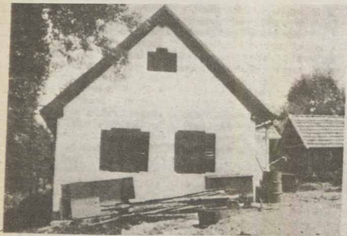
Obnovljeno pročelje stare hiše.
