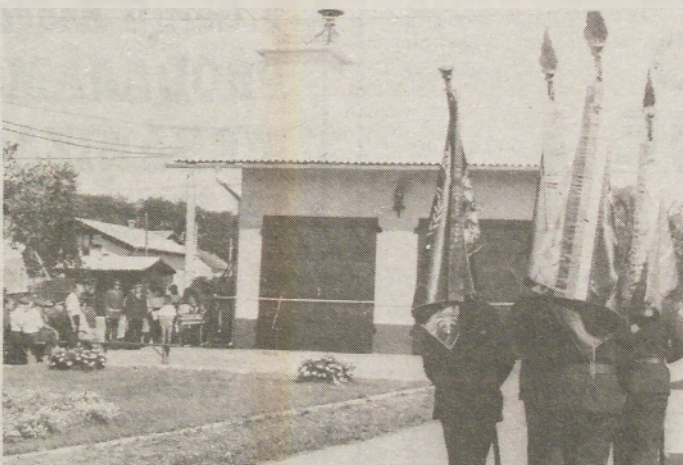
Obnovljeni gasilski dom v Ivancih je v ponos krajanov. Za njegovo obnovo so prispevali sredstva vsi krajan, veliko pa so pomagali tudi s prostovoljnim delom. JD
