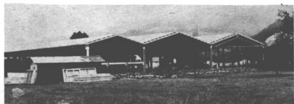
Nova proizvodna hala Tovarne meril TRISO Slovenj Gradec, ki jo gradijo v Pamečah, je že pod streho. Predvidoma do konca leta bodo v nove prostore preselili obrat plastike ter kovinski obrat z orodjarno.
