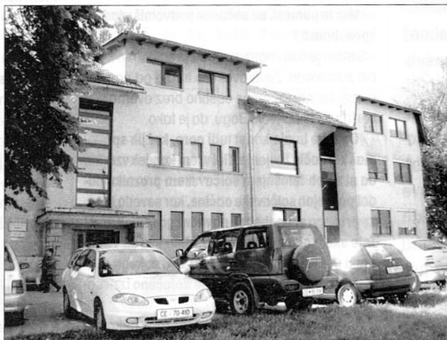
Zdravstvena postaja v Nazarjah je v zelo slabem stanju, inštalacije so zastarele, izolacija je zanič... (foto: Franci Kotnik)
