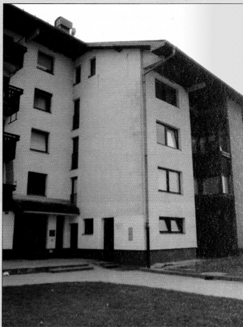
Na stanovanjskem bloku na Zadrebki cesti 11 v Nazarjah, kjer je tudi njegova pisarna, je Habit začel s sanacijo strehe, ki bo stanovalcem zagotovila višje udobje bivanja (foto: Tatiana Golob)
