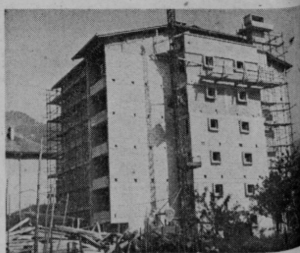
Splošno gradbeno podjetje Hrastnik, v njegovem sestavu dela radeška Obnova kot TOZD, gradi v Radečah 24-stanovanjski blok. Vseljiv bo septembra.
