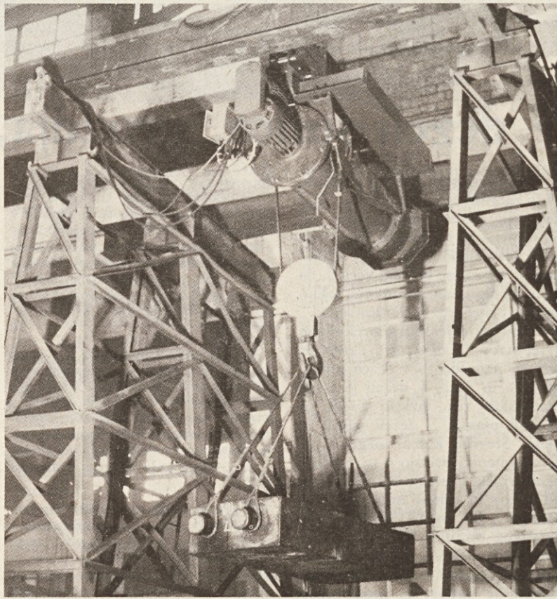
Prototip desettonskega elektrovitla. Višina dviga bremena je največ 40 metrov (Foto: O. Zagoričnik)
