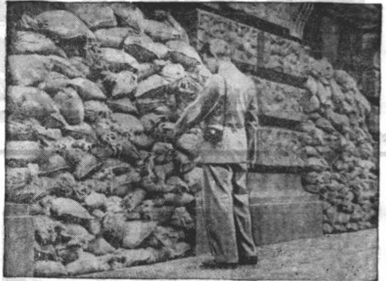
VHOD V ZAKLONIŠČE PROTI ZRAČNIM NAPADOM je marsikod v Angliji zavoljo večje varnosti zaščiten s vrečami peska
