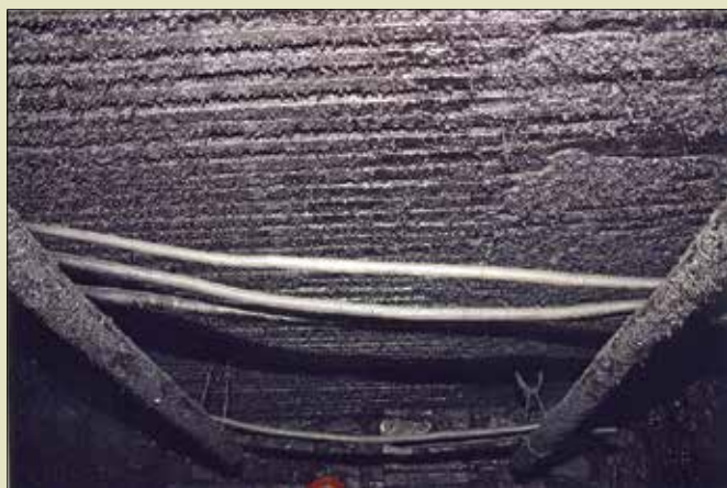
Strop dimnice v Kumprejevi hiši. Odprta ognjišča niso zahtevala, da ne bi bil strop lesen, sestavljen iz okroglega lesa. (Foto: Franjo Atelšek)
