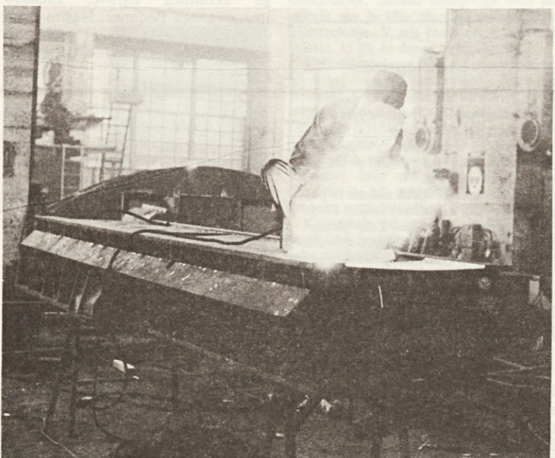
Varjenje podložne plošče za dizel motor — naročnik je ladjedelnica Split (Foto: E. L.)
