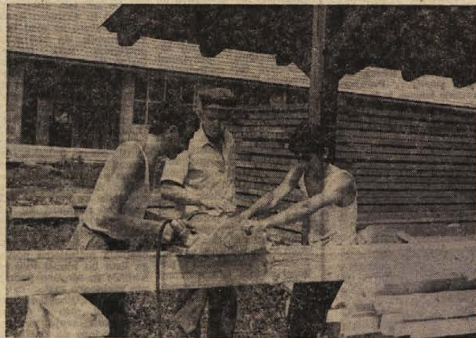
Vajenca poklicne tesarske šole uporabljata pod nadzorstvom Instruktorja električni skobelnik. V poklicni šoli se vajenci priučujejo delu z najsodobnejšimi delovnimi pripravami in na najsodobnejše načine.
