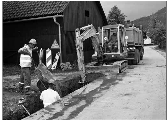
Zaključna faza rekonstrukcije vodovoda na Ljubnem (Foto: Marija Lebar)
