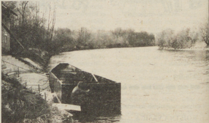
Hrastov les je predrag, tudi mojstrov ni, zato so namesto lesenih »kumpov« zgradili 13 metrov dolge železne. Na obrežju je novo tudi sidrišče, kamor bodo mlin potegnili, če bi rekla grozila, da bi ga odplavila.
