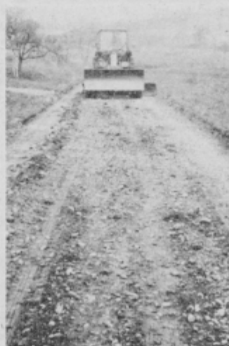
Na cesti Žamenci — Bresnica, ali so to že priprave na asfalt?
