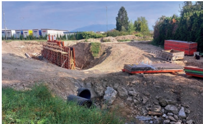
Takole je bilo videti delovišče mengeške vtočne zapornice (»zaturnice«) konec avgusta. Čeprav je minilo šele nekaj več kot leto dni, se zdijo lanskoletne poplave kot priivid nečesa nemogočega. Pomnimo, zadnje besedo ima vedno narava.
