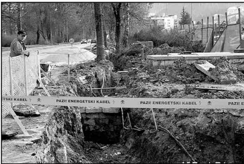
Največ denarja so lani namenili za obnovo toplovodnih vodov.
