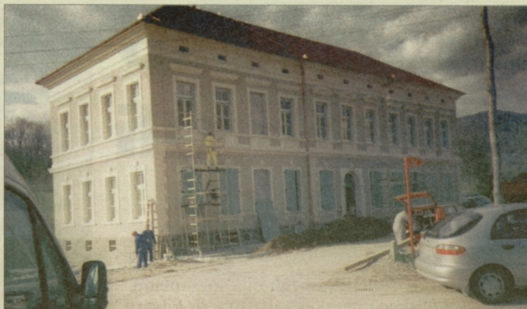
Obnovljena šola v Donački Gori v svojem nekdanjem sijaju. Tri desetletja je zdržala brez večje obnove.
