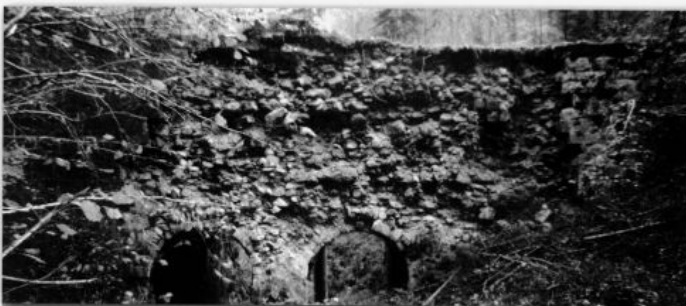
Močno poškodovane Kanomeljske klavže pred začetkom obnove, 27. 10. 2001.
