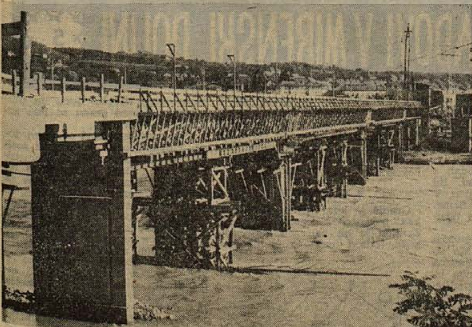
KRŠKI MOST V LESENEM OKLEPU. Novi most čez Savo v Krškem je največja gradnja v tej občini. Pretekli teden so delavci PIONIRJA zalili z betonom bodočo vez med obema bregovima Save (Foto: Vili Videnič, drugo mesto za fotografijo tedna, ORWO NP 18, 8, 1/125).
