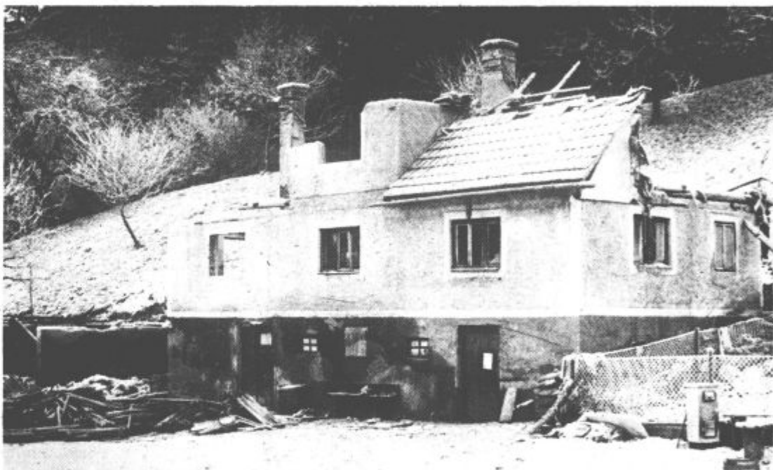
Od hiše in gospodarskega poslopja je ostalo le še golo zidovje
