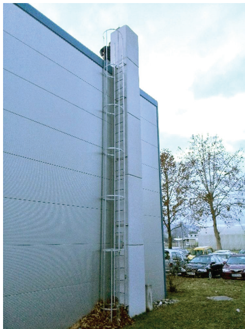
Slika 1: Stabilizacija referenčne točke z masivnim betonskim dimnikom in prikaz prisilnega centriranja antene GNSS na vijak z ustreznim navojem.
