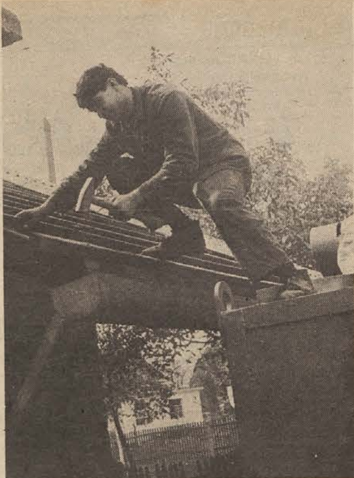
Kolektiv dobavne livarne dela v dveh razpadajočih zgradbah, zato komaj čaka, da se bo preselil v nove delavnice zunaj vasi. V stare prostore niti strojev ne morejo spraviti, in kot vidite na sliki, so morali najprej odkriti streho, šele potem so lahko postavili v delavnico nov stroj. (Foto: J. Teppey)
