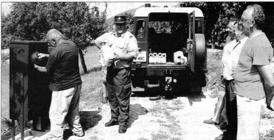
S 120 metri cevi, ki so jih namestili v omarico poleg hidranta, bodo v Kolovratu mirneje spali (foto: Benjamin Kanjir)
