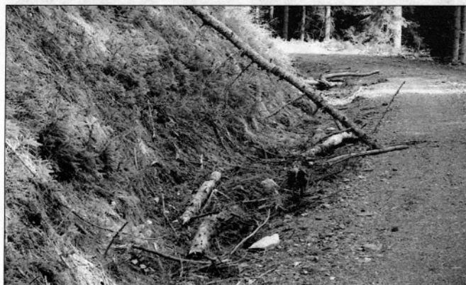
V jarkih in propustih naj ne bo vej in vrhačev (foto: Damjan Jevšnik)
