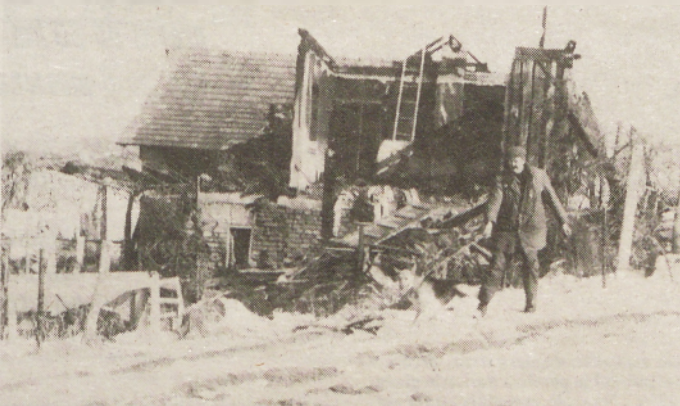
Štefana Zrima je v nedeljo navezgodaj prebudil nenavaden lajež hišnega čuvaja Stricija. Je vzrok požara pepel, ki naj bi ga odlagal v bližini hiše, ali pa dotrajana električna instalacija? Oškodovani je takorekoč ob vse, le rešitelj — čuvaj Strici mu je ostal. Foto: S. S.
