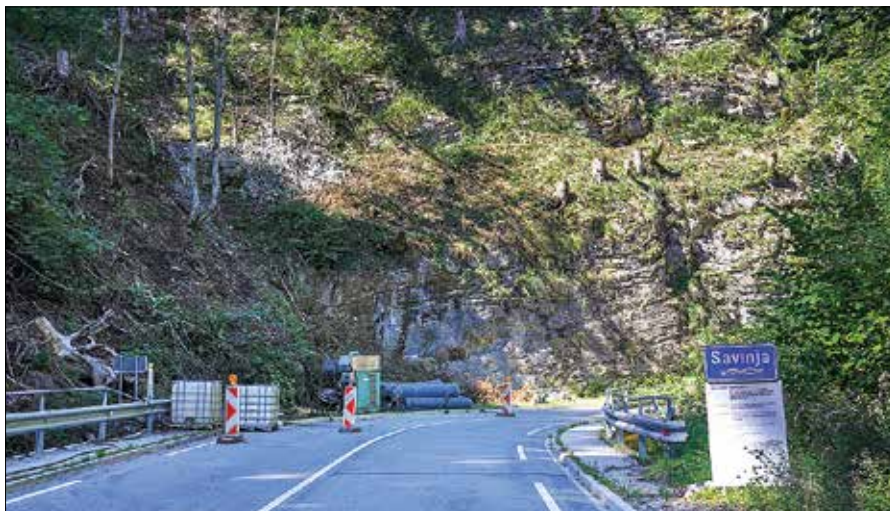
Delna zapora ceste proti Logarski dolini zaradi nameščanja zaščitnih mrež proti padanju kamenja
