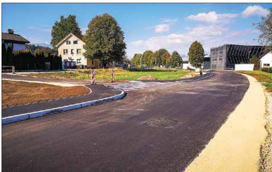
S povezovalne ceste so že narejeni izvozi.
