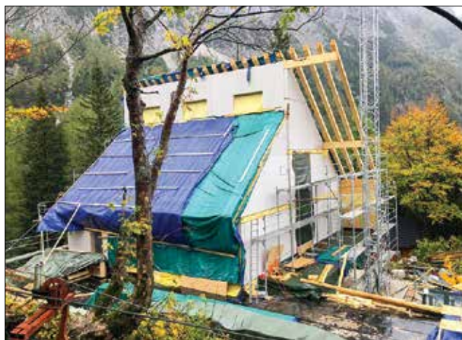
Pred novim snegom želijo prekriti streho novega Frischaufovega doma, zmontirati vrata in okna, da bodo lahko začeli z montažo notranjih inštalacij. (Foto: Rok Bordon)
