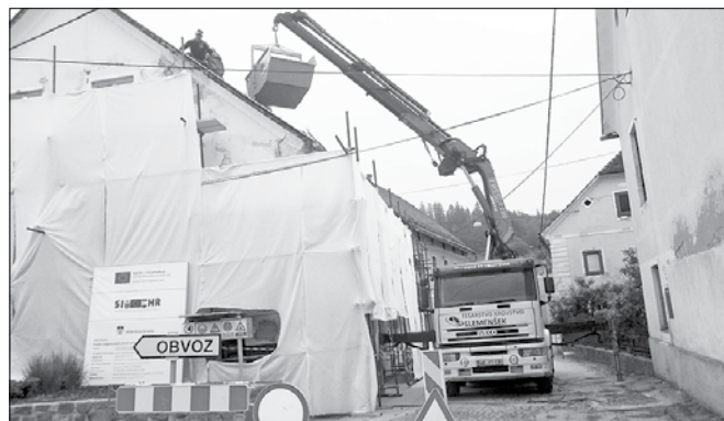
Dela na sanaciji nekdanje hranilnice (Foto: LM)
