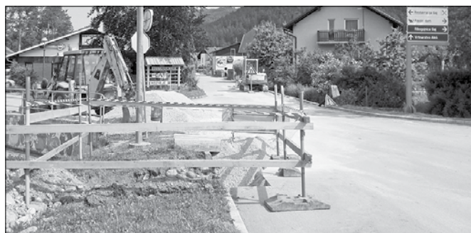
Začetek del na cesti v Loke (Foto: ŠS)
