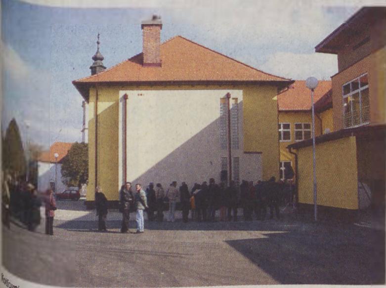
Kotlovnica ob šoli
