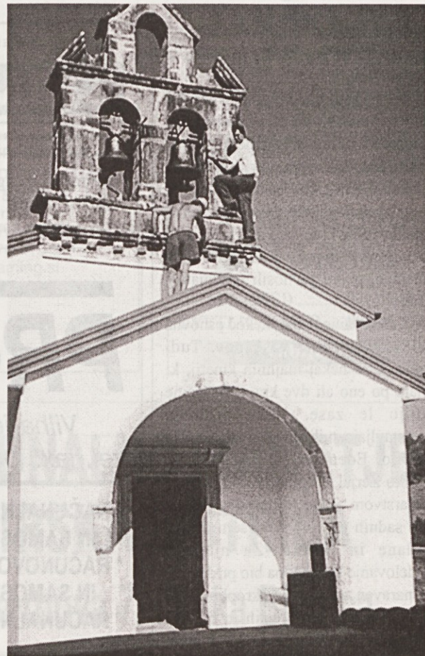
Zaključna dela pri postavitvi zvonov
