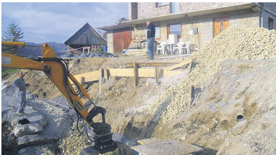
Sanacija dveh največjih plazov v občini je izjemnega pomena za družini Vogrinc in Zalokar.
