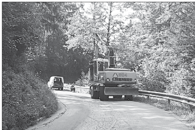
Delavci podjetja GP Brlec iz Krnice so utrdili steno cestišča proti vodi in za nekaj časa preprečili nadaljnjo erozijo. (Foto: Benjamin Kanjir)
