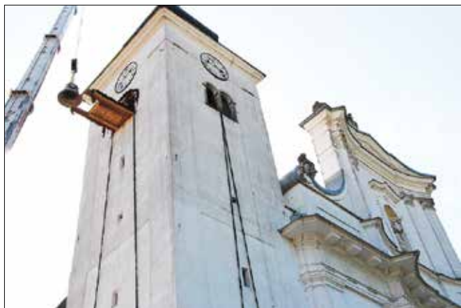
Z dvigalom so zvonove varno spravili v zvonik. (Foto: Štefka Sem)
