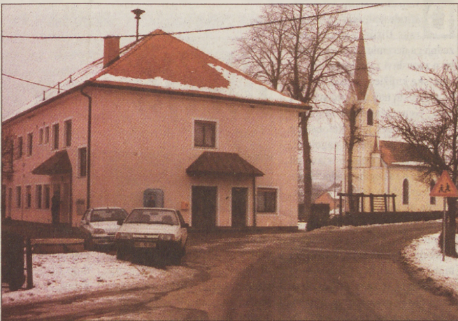
Nekdanji združni dom v Filovcih so lepo obnovili in olastninili: dve tretjini sta v lasti KS, ena tretjina pa je občinska.
