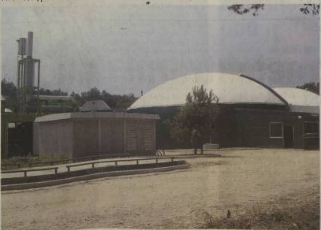
Pod temi kupolami bo potekala fermentacija organskih odpadkov, ki bodo vir električne energije.
