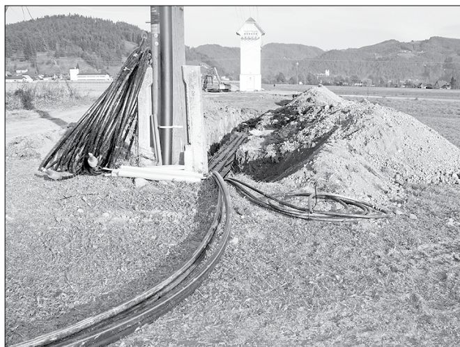
Trenutno se izvajajo izkopavanja za kabliranje na Rečici ob Savinji.
