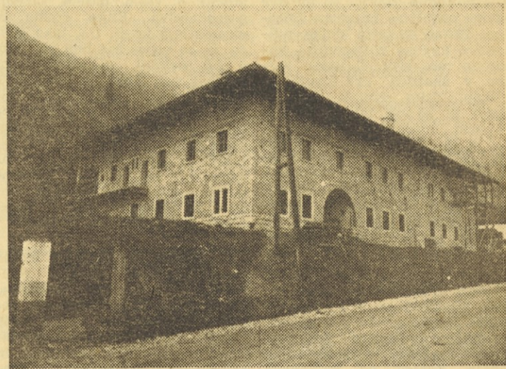
Na dverih Kroke so delavci »Plamena« zgradili kulturni lep in svetel dom. Ponosno pokažejo prišlecu dom — žarišče kulturnega in družabnega življenja — plod žuljavih rok kroparskih žebjarjev
