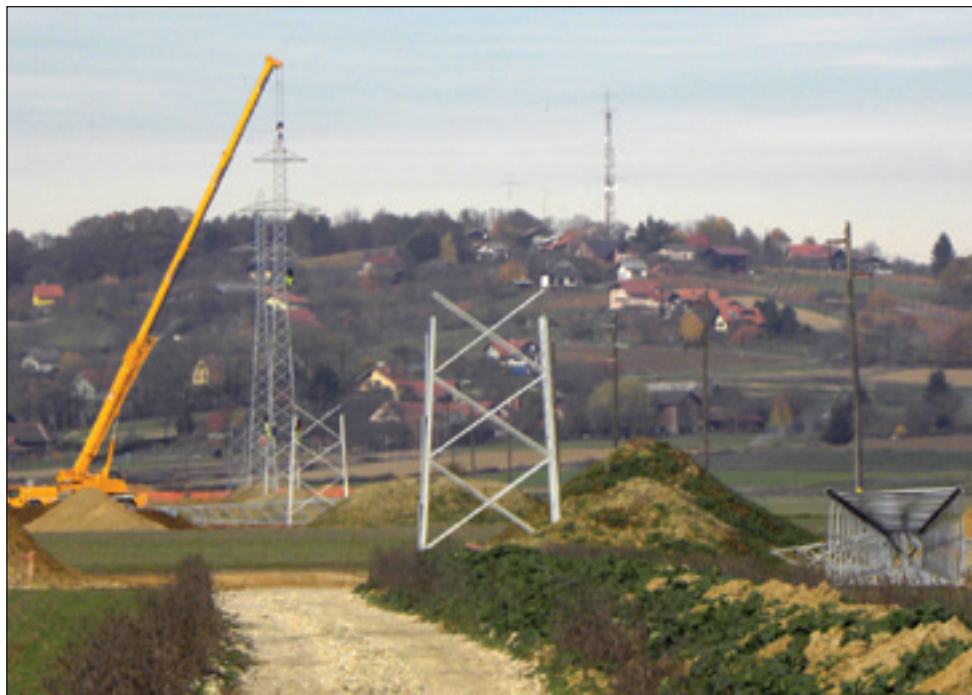
Gradnja daljnovoda, ki bo zagotovil energijo za elektrifikacijo železniške proge med Mursko Soboto in Hodošem oziroma do madžarske meje, do koder že vozijo električne lokomotive, ne razpadajoče in močno glasne dizelske, ki ropotajo po Sloveniji
