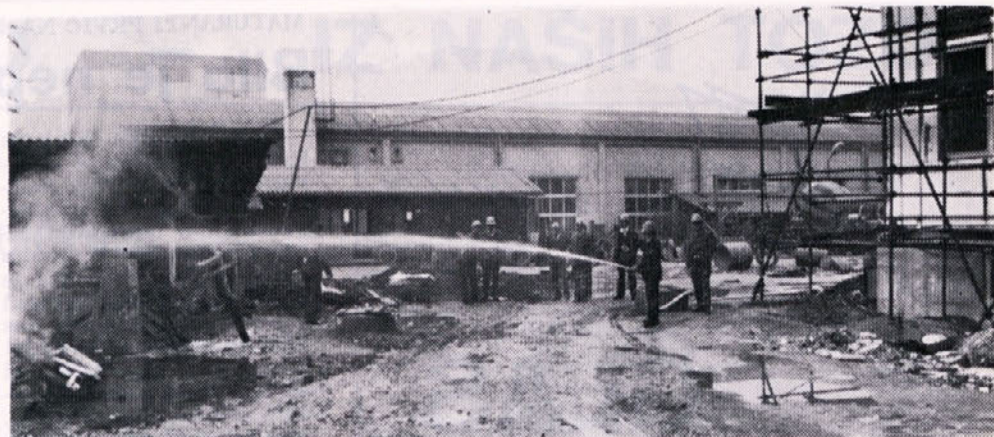
Gasilska enota je z uporabo hidranta in ročnih gasilskih aparatov gasila požar.
