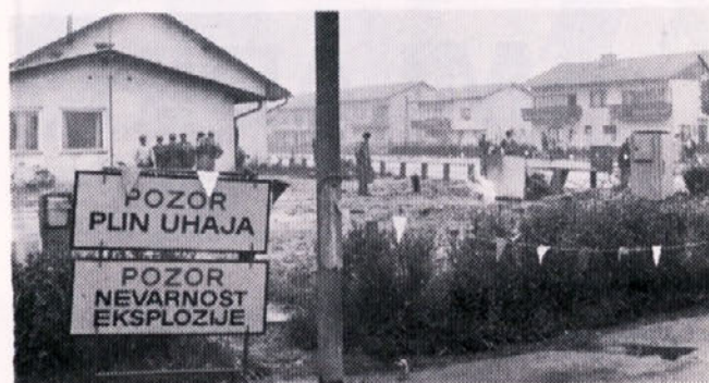
Enote narodne zaščite so zagotovile zavarovanje poškodovanih zgradb in instalacij
