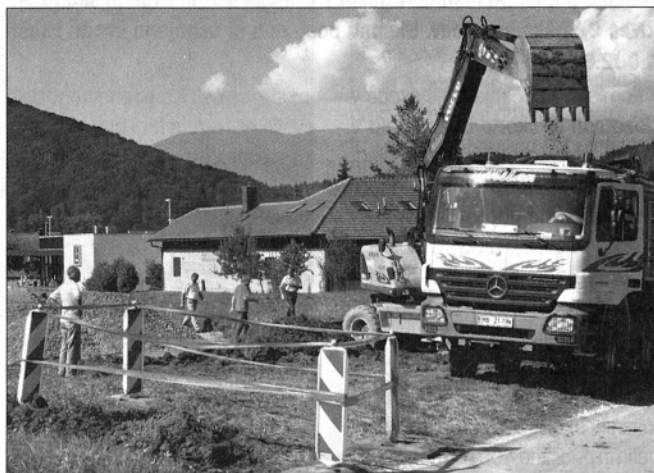
Delavci podjetja Strabag zaključujejo z izkopi za novo cesto proti Ljubiji (foto: Benjamin Kanjir)
