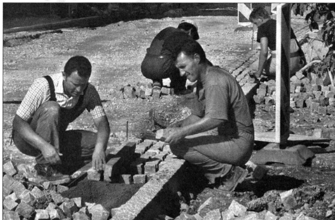
V središču Mozirja trenutno potekajo intenzivna dela pred polaganjem asfaltne prevleke (foto: Benjamin Kanjir)
