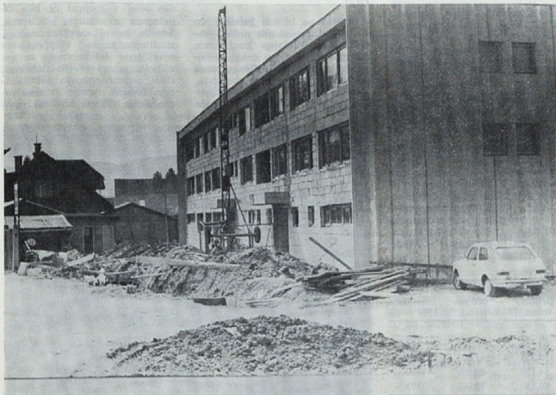
Novo tovarniško poslopje TOZD Montažni objekti že dobiva končno podobo
