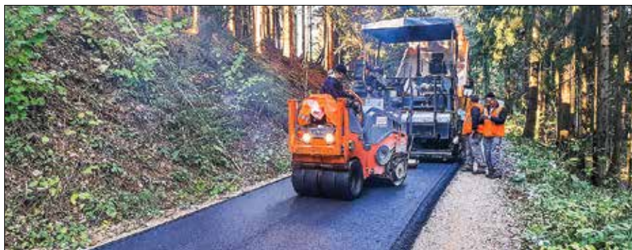
Gradbena dela na saniranem cestnem odseku Čeršek-Krnica-Grabner (foto: arhiv občine)
