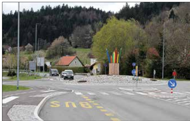
Z izgradnjo krožišča pri odcepu za osnovno šolo se je izboljšala prometna varnost v tem delu kraja. (Foto: Benjamin Kanjir)
