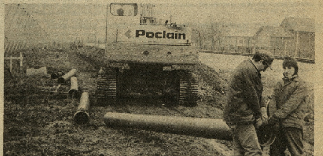
Dela pri namakalnem sistemu Breg, ki jih izvaja Strojna žalec, potekajo nemoteno. Pravijo, da bodo z deli, če bo vreme takšno kot do sedaj, zaključili sredi marca. Na sliki: Delavci Strojne delajo kljub mrazu.
