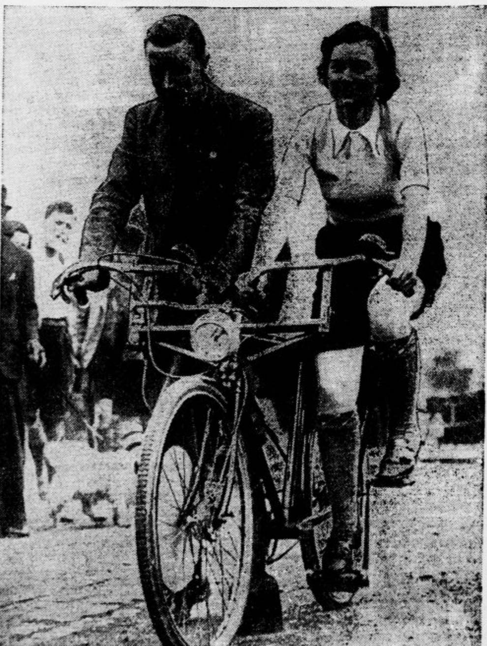
Na Angleškem so izdelali nov tip bicikla z dvema ročajema in dvojnimi pedal. Posebnost tega vozila je, da ima samo dva kolesi
