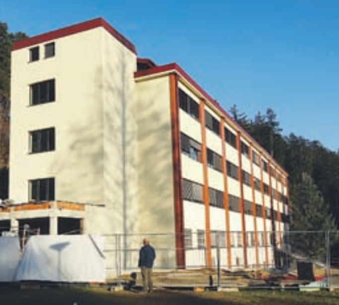
Vitalni del bolnišnice – objekt Planika – naj bi bil do konca januarja prihodnje leto v celoti obnoven.
